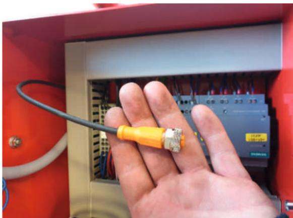
Die Anschlussbuchse des Empfängers aufstecken (hierbei beachten, dass die Führungen übereinstimmen) bis zum Gewinde und dann verschrauben.
