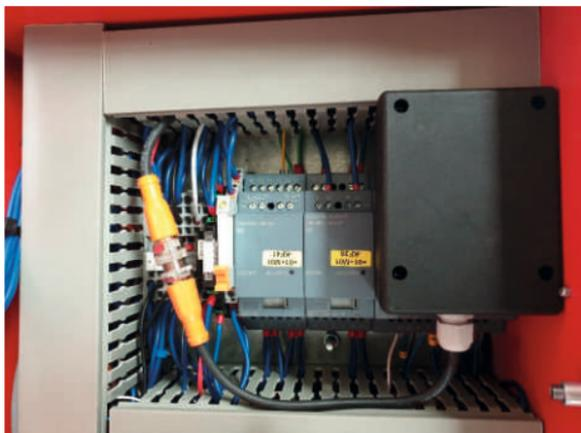
Den fertig angeschlossenen Empfänger legen Sie wie abgebildet auf die Steuerung.
